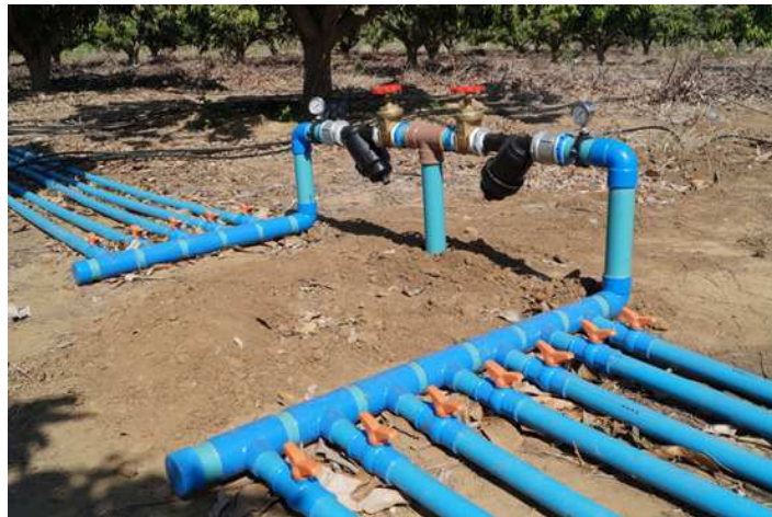
Figura 3 - Sistema de válvulas para controle das lâminas de irrigação.
