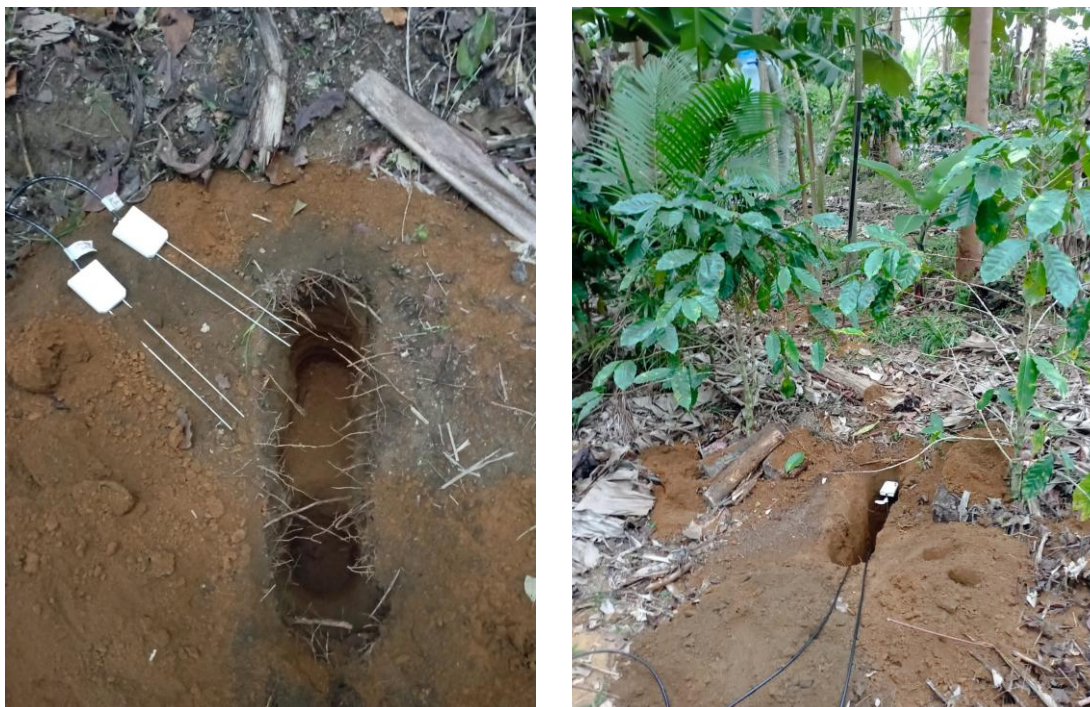
Figura 8: Instalação dos sensores de umidade em trincheira cavada sob as linhas de plantio
