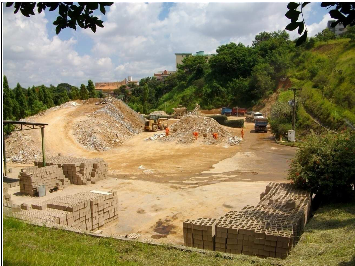
Figura 4 – Vista do pátio de processamento da Usina de Reciclagem de Estoril
