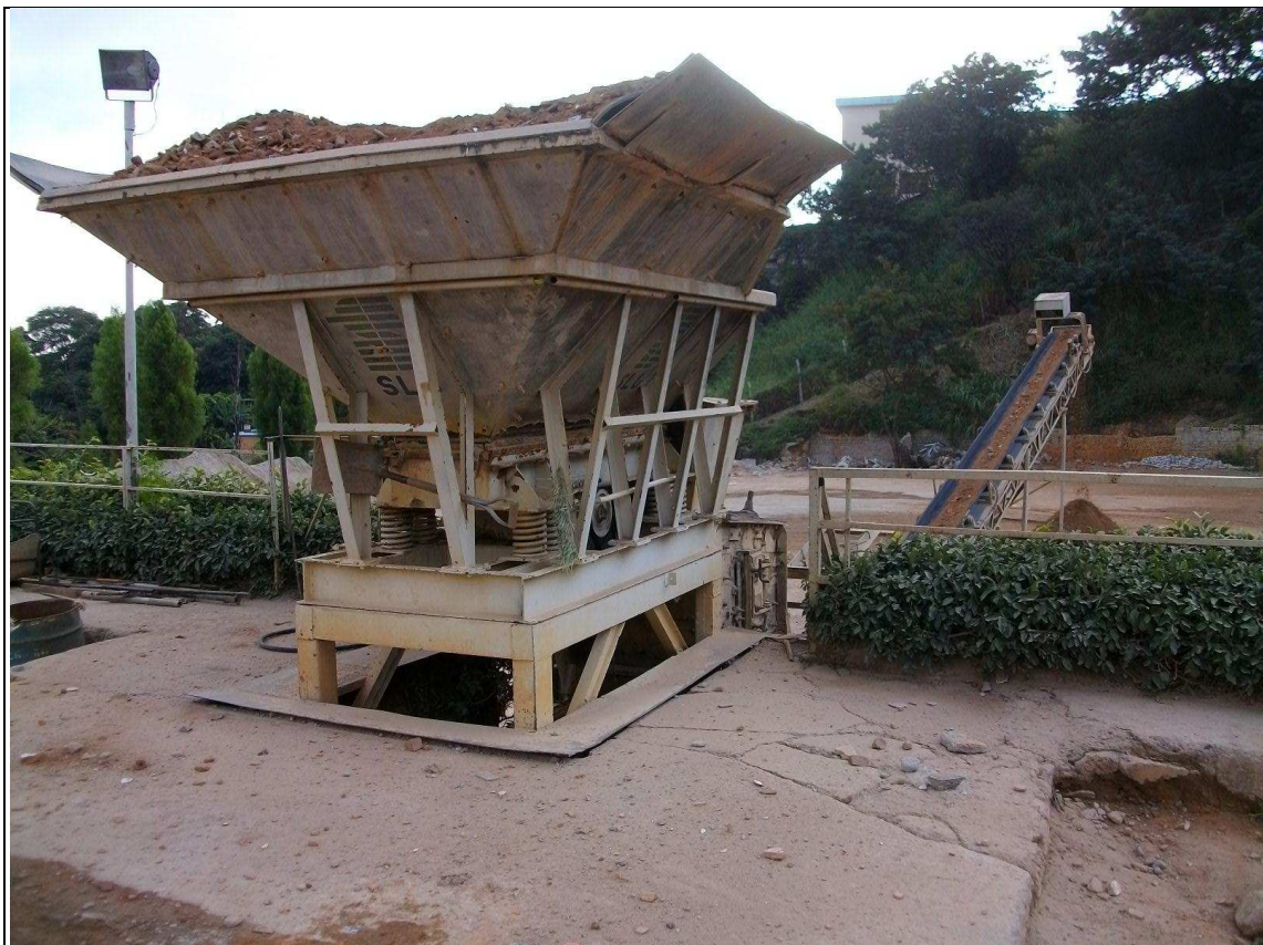
Figura 12 – Vista geral do britador em atividade
