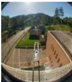
Vista da instrumentação externa a partir da janela da sala
