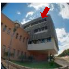
Vista da instrumentação externa a partir da calçada do edifício
