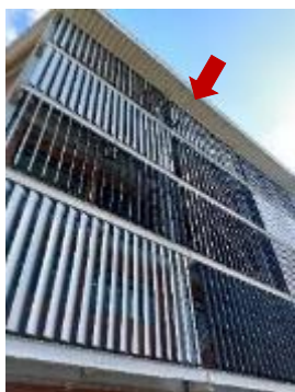
Vista da instrumentação externa a partir da calçada do edifício
