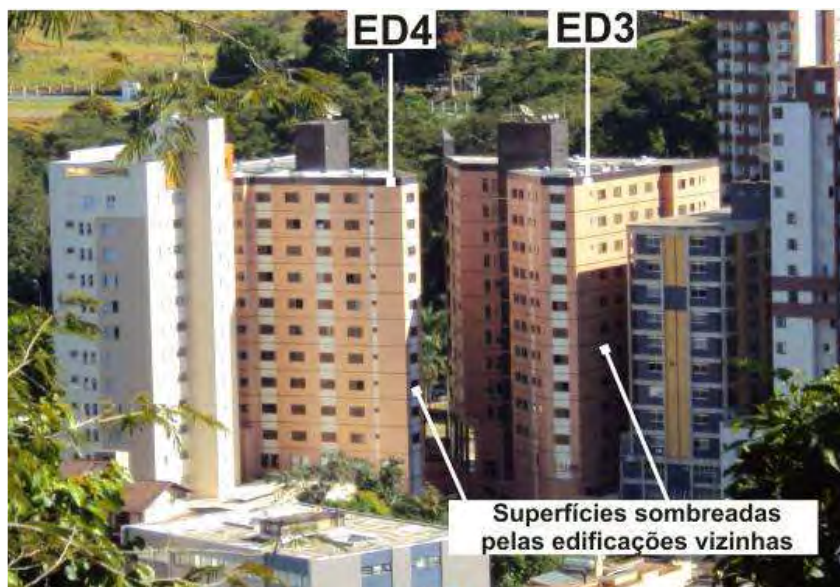
Figura 28: Edificação ED3 com fachadas sombreadas por edificação vizinha às 15h.
