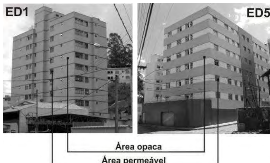
Figura 35: Amostra da relação entre áreas opacas e permeáveis das superfícies externas das edificações ED1 e ED5 que, além da abertura em fachadas, possuem poços de ventilação e iluminação.
