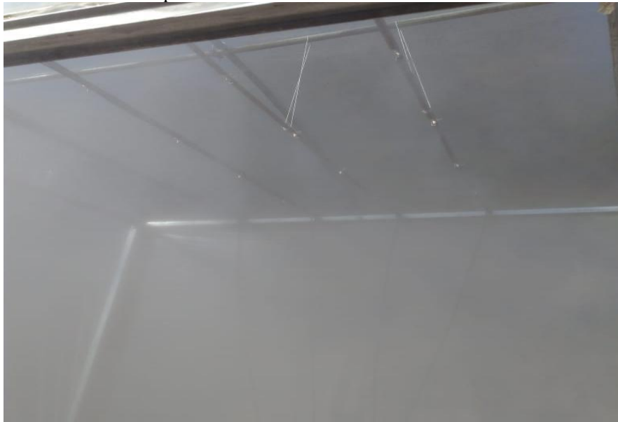
Figura 23 - Névoa formada pelo sistema de resfriamento adiabático dentro da casa de vegetação
