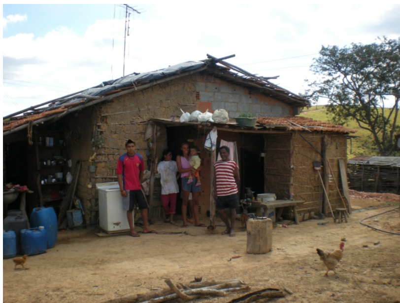
Figura 6: Casa de assentado (parte alvenaria e parte barro)
