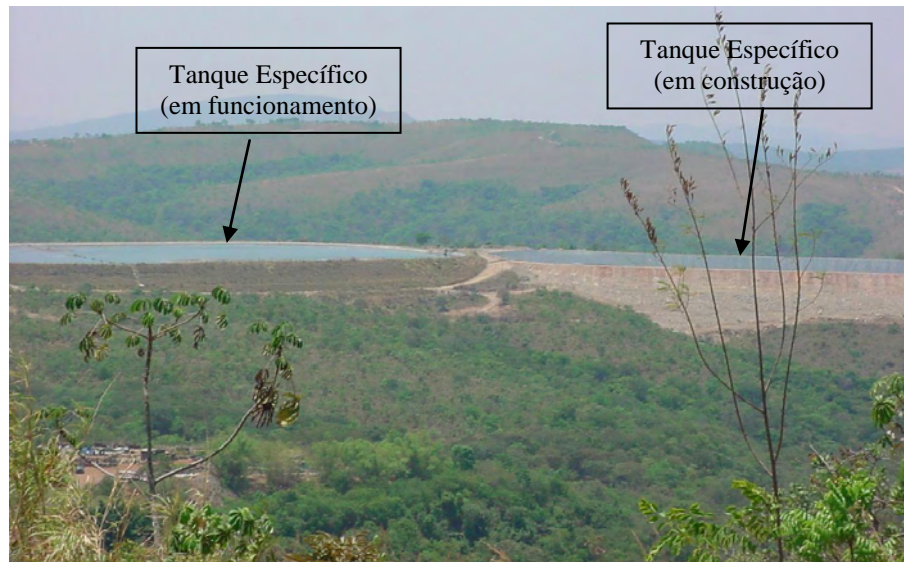
Figura 1.1 – Imagem ilustrando os dois tanques específicos, um em funcionamento e outro em construção.
