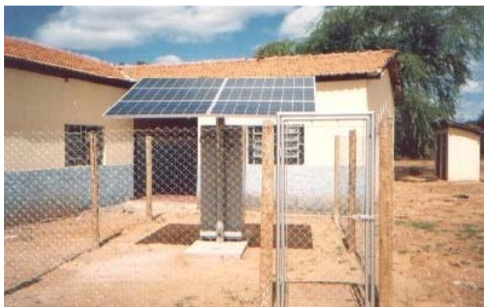
Figura 2.3. Sistema fotovoltaico instalado em escola, pela CEMIG, pelo projeto PRODEEM.
