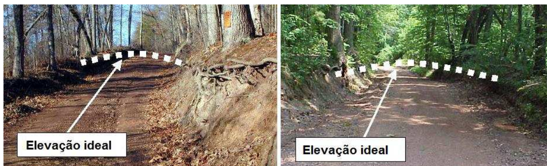
Figura 21: Ilustração de sugestões de reconstituição de via de terra com elevação do greide e seção transversal (PDT, 2007).
