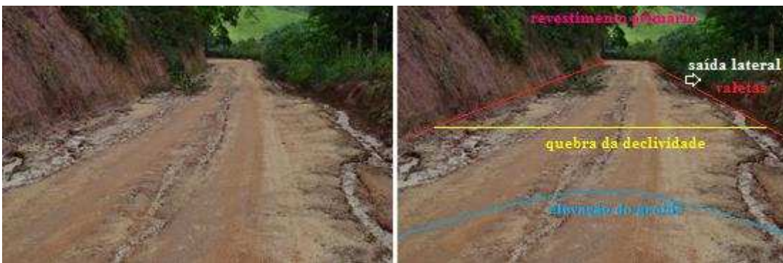
Figura 54: Condições de rolamento do trecho 3 em janeiro de 2016.
