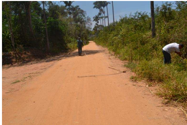
Figura 41: Trecho 6, apresentando-se as unidades em tangente com solo residual maduro.
