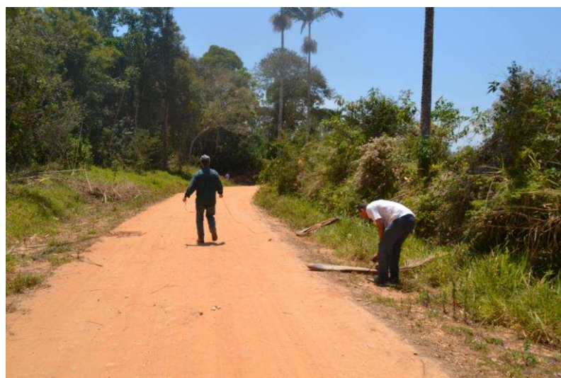
Figura 37: Trecho 4, com unidade em solo do horizonte b e em tangente.
