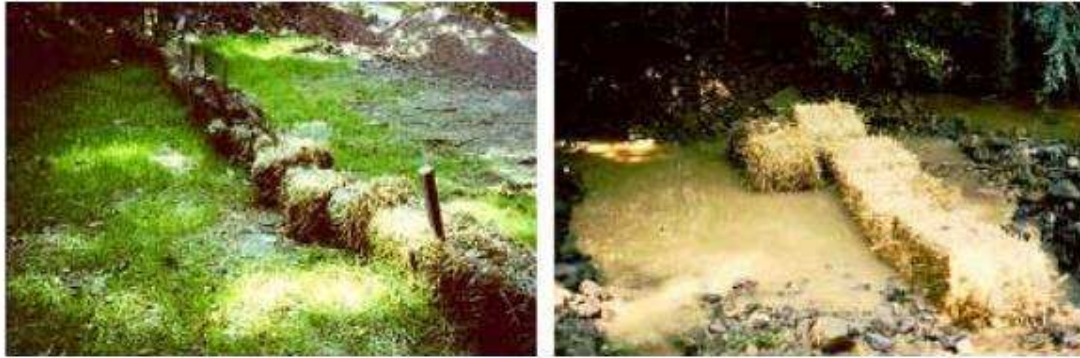
Figura 12: Barreiras de fardos de palha ( Straw Bale Barriers ) aplicados numa situação em que o sistema de fardos de palha está entrando em colapso.
