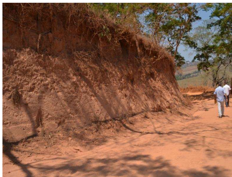
Figura 35: Trecho 3, apresentando-se unidade em solo residual jovem e em curva.
