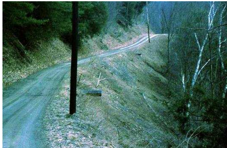
Figura 18: Ilustração de solução de quebra de declividade longitudinal de via de terra, conforme recomendado pelo Departamento de Transportes da Pensilvânia (PDT, 2007).
