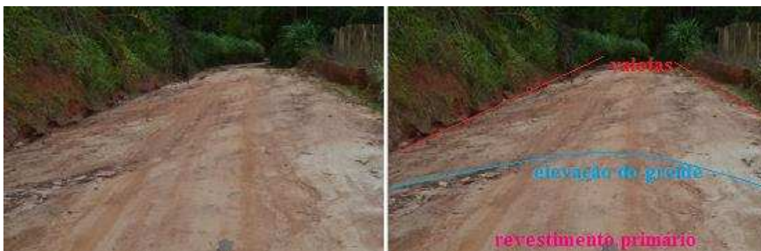
Figura 52: Condições de rolamento do trecho 1 em janeiro de 2016.
