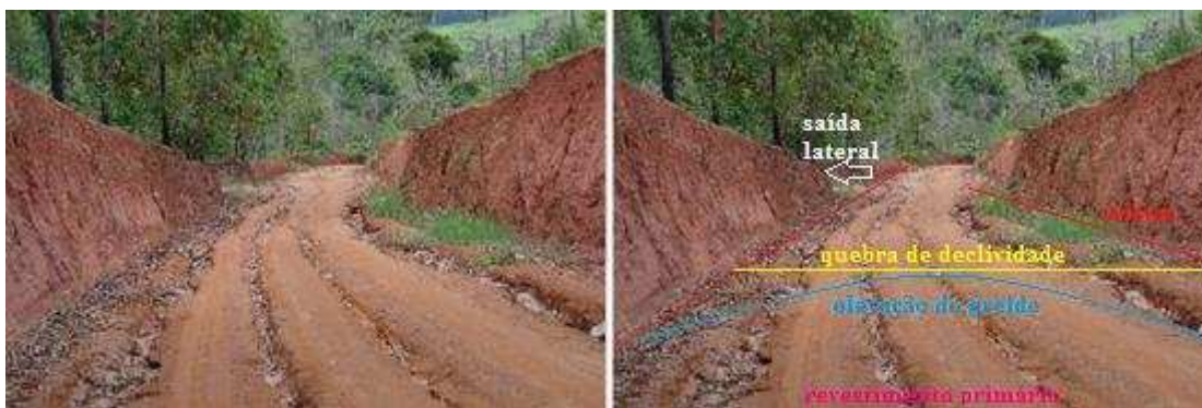
Figura 56: Condições de rolamento do trecho 5 em janeiro de 2016
