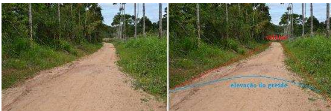
Figura 57: Condições de rolamento do trecho 6 em janeiro de 2016
