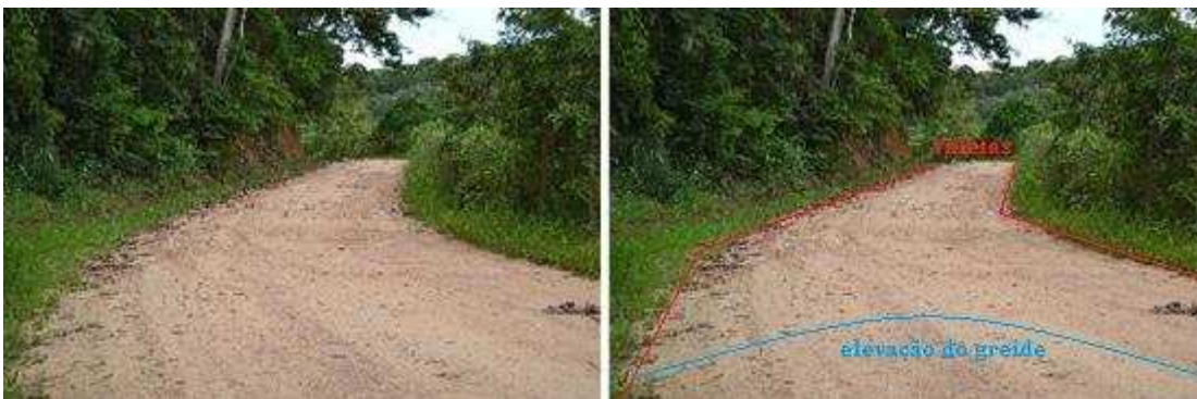
Figura 55: Condições de rolamento do trecho 4 em janeiro de 2016.
