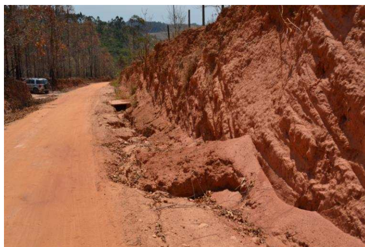
Figura 39: Trecho 5, em corte e com declive com sulcos erosivos acentuados, ilustrando-se a ocorrência de unidade em solo residual jovem.
