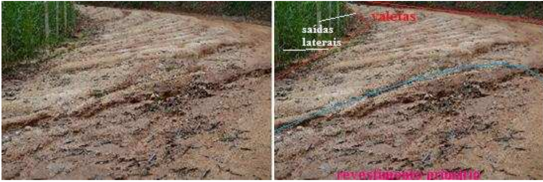
Figura 53: Condições de rolamento do trecho 2 em janeiro de 2016.
