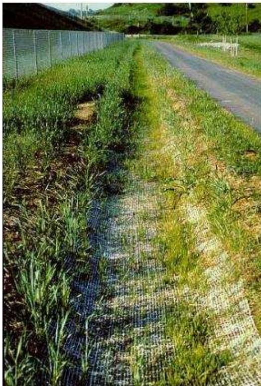
Figura 16: Geomanta recobrimdo a sarjeta até a estabilização da cobertura vegetal.
