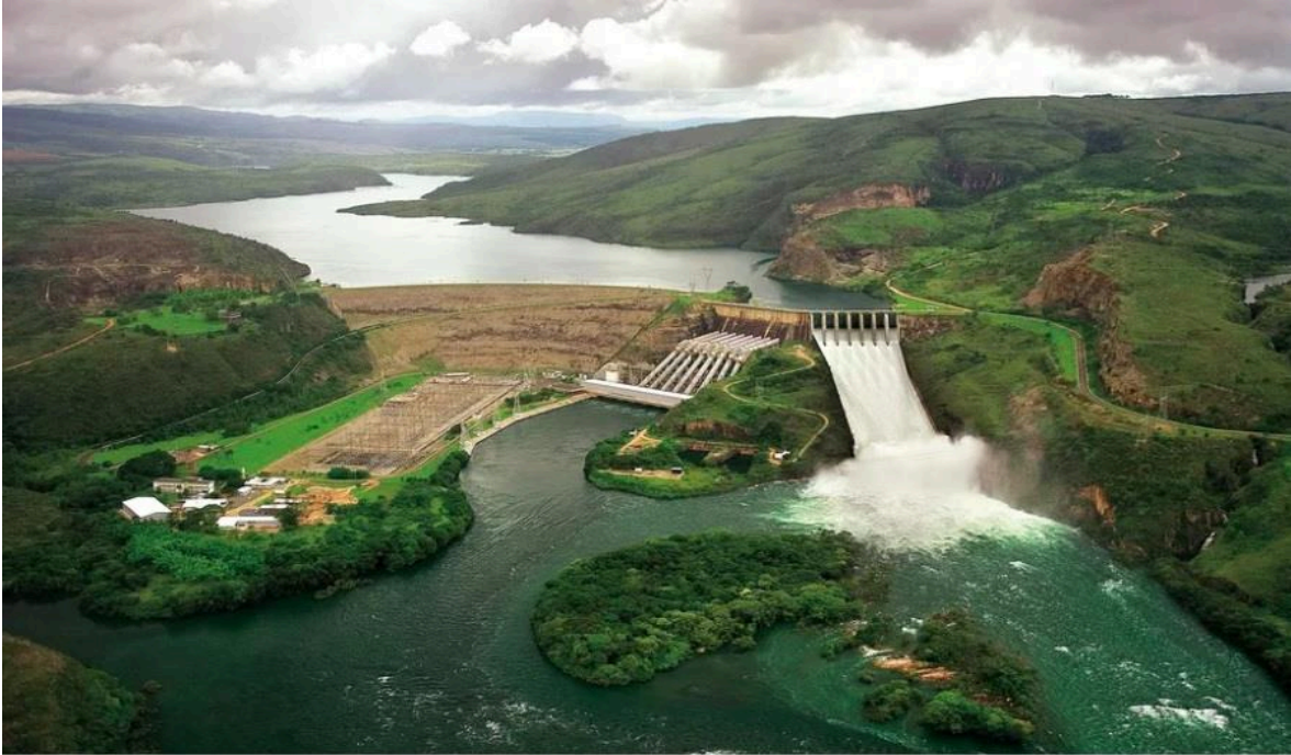
Figura 4 – Usina Hidrelétrica de Furnas
