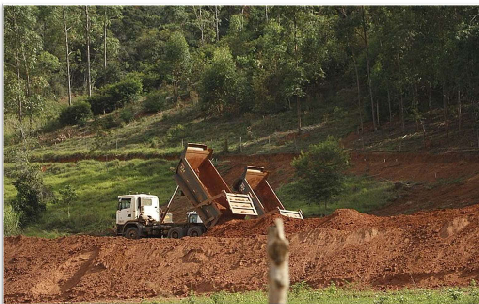
Foto 2. Terraplanagem da área que recebeu a planta de beneficiamento a úmido, 2019.
