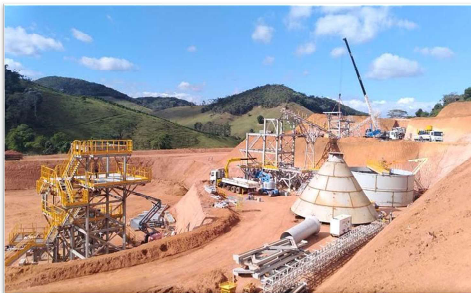
Foto 4. Instalação da UTM à úmido, 2019
