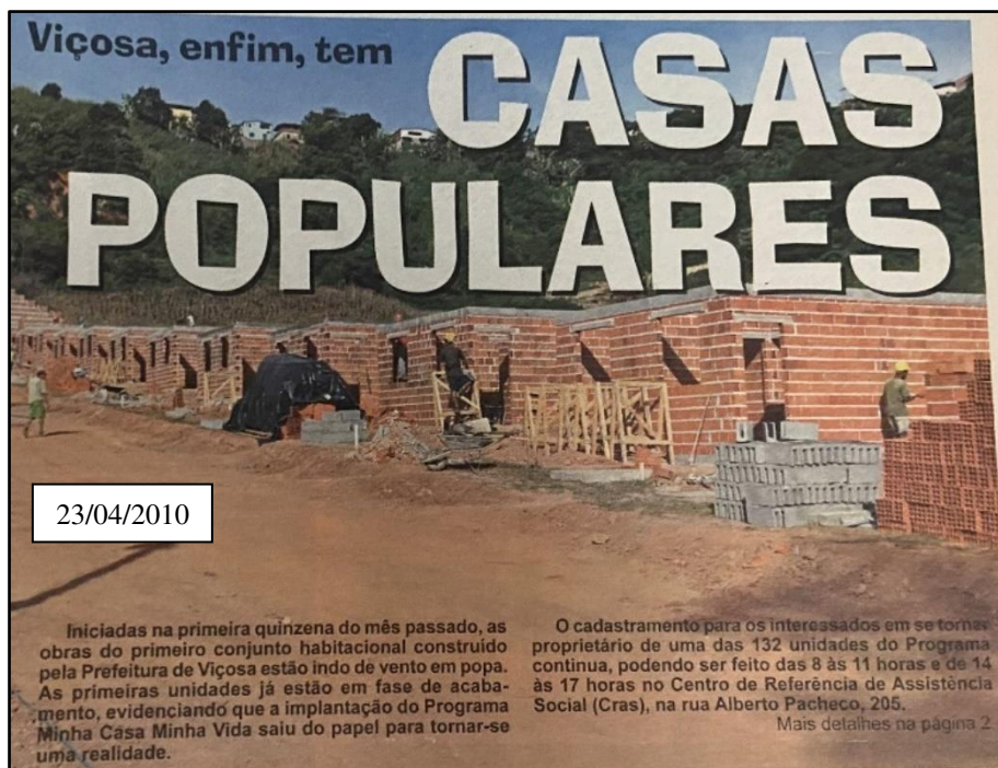
Figura 23 – Obras do primeiro conjunto habitacional do MCMV
