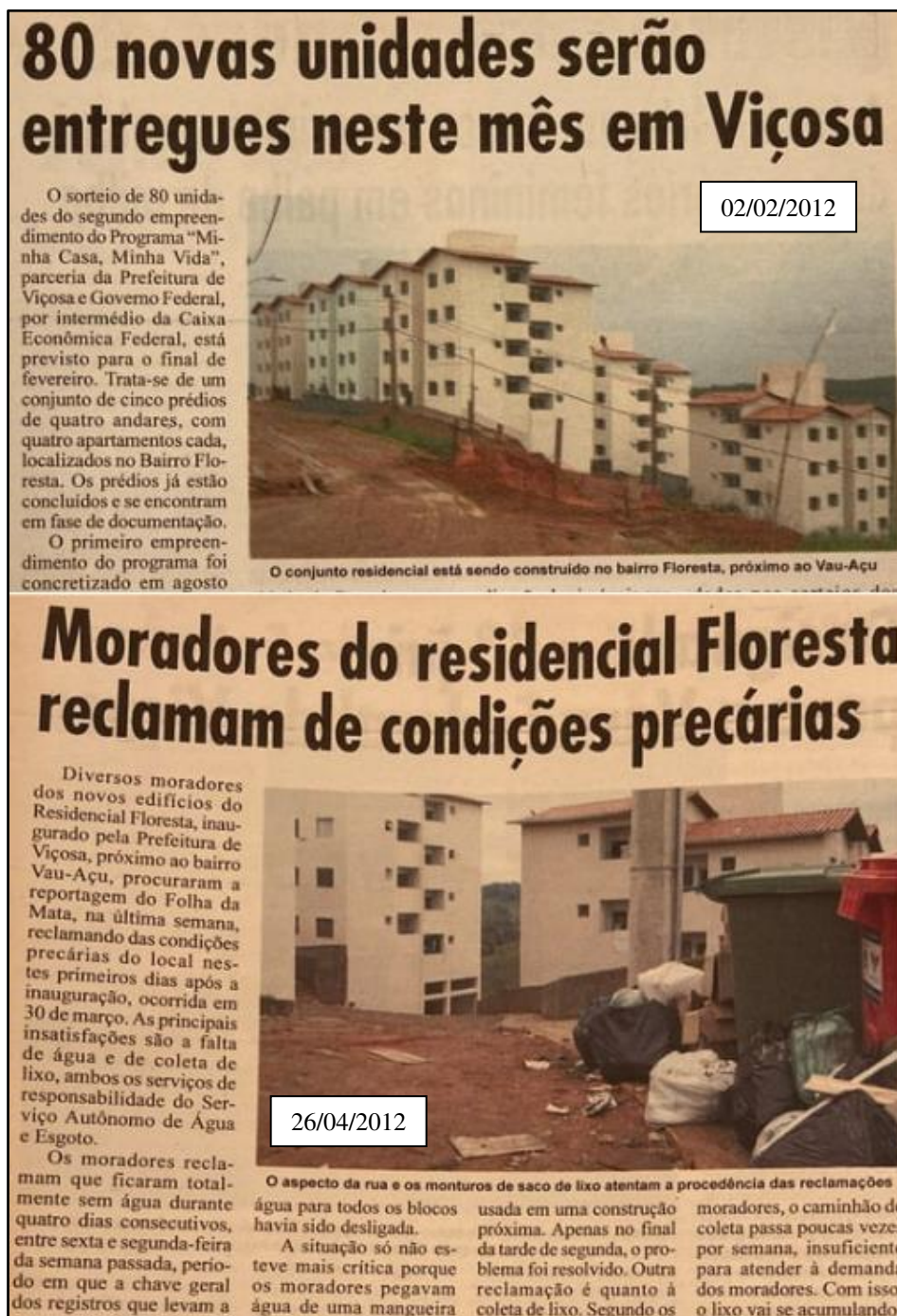
Figura 24 – Obras do segundo conjunto habitacional do MCMV
