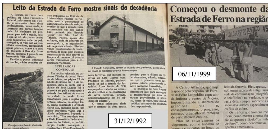
Figura 11 – A ferrovia cai em desuso
