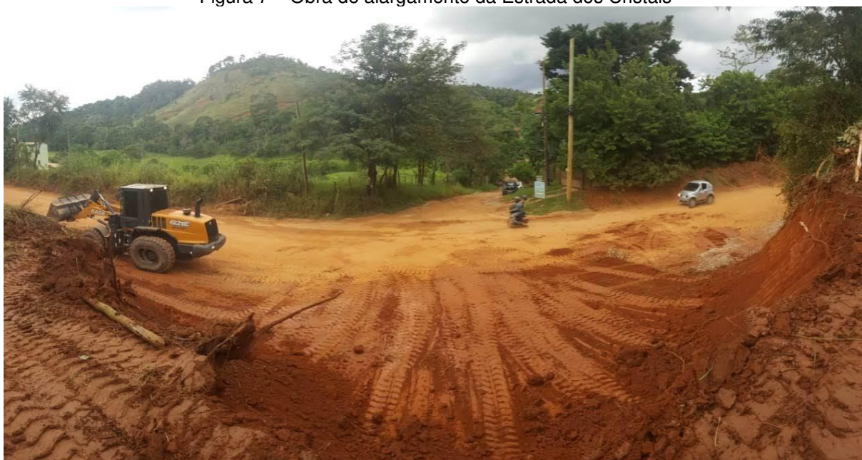
Figura 7 – Obra de alargamento da Estrada dos Cristais
