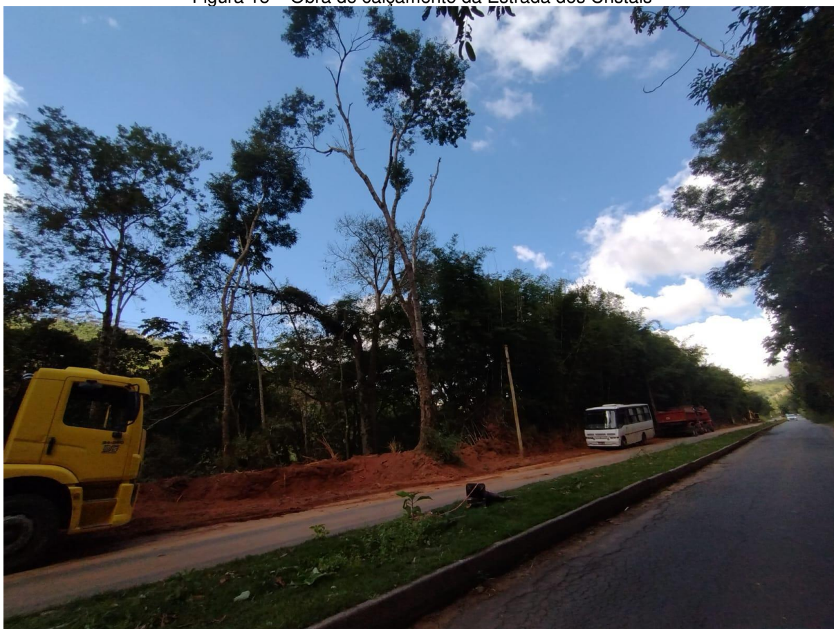
Figura 15 – Obra de calçamento da Estrada dos Cristais
