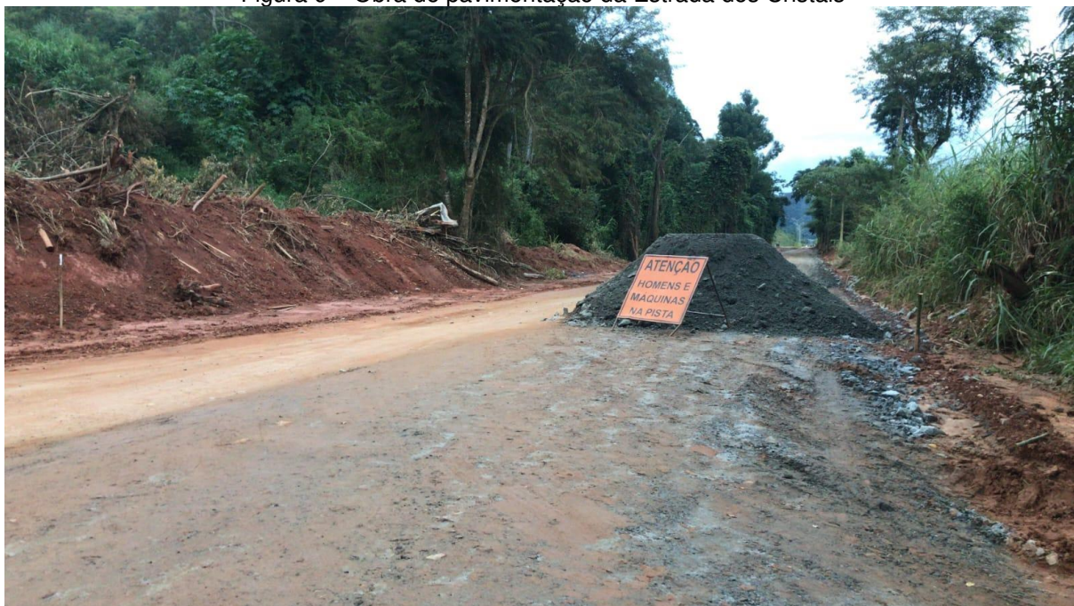
Figura 9 – Obra de pavimentação da Estrada dos Cristais
