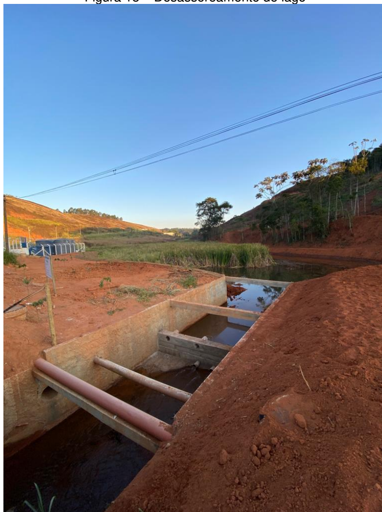
Figura 18 – Desassoreamento de lago
