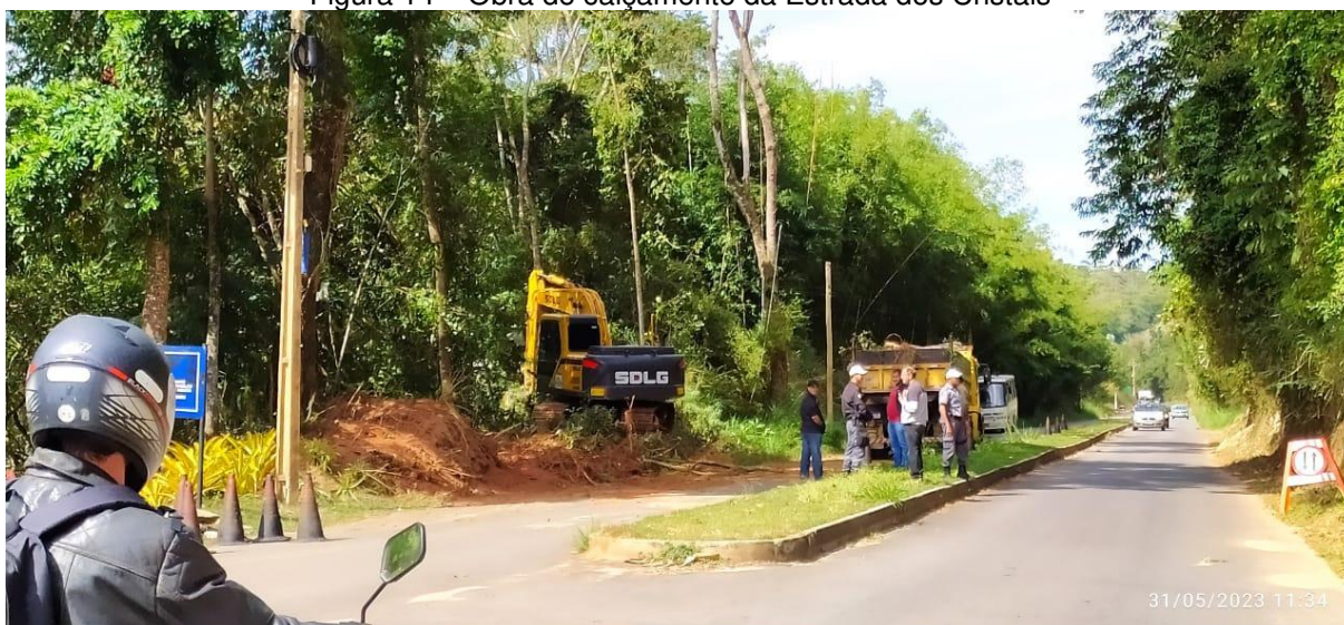
Figura 14 – Obra de calçamento da Estrada dos Cristais
