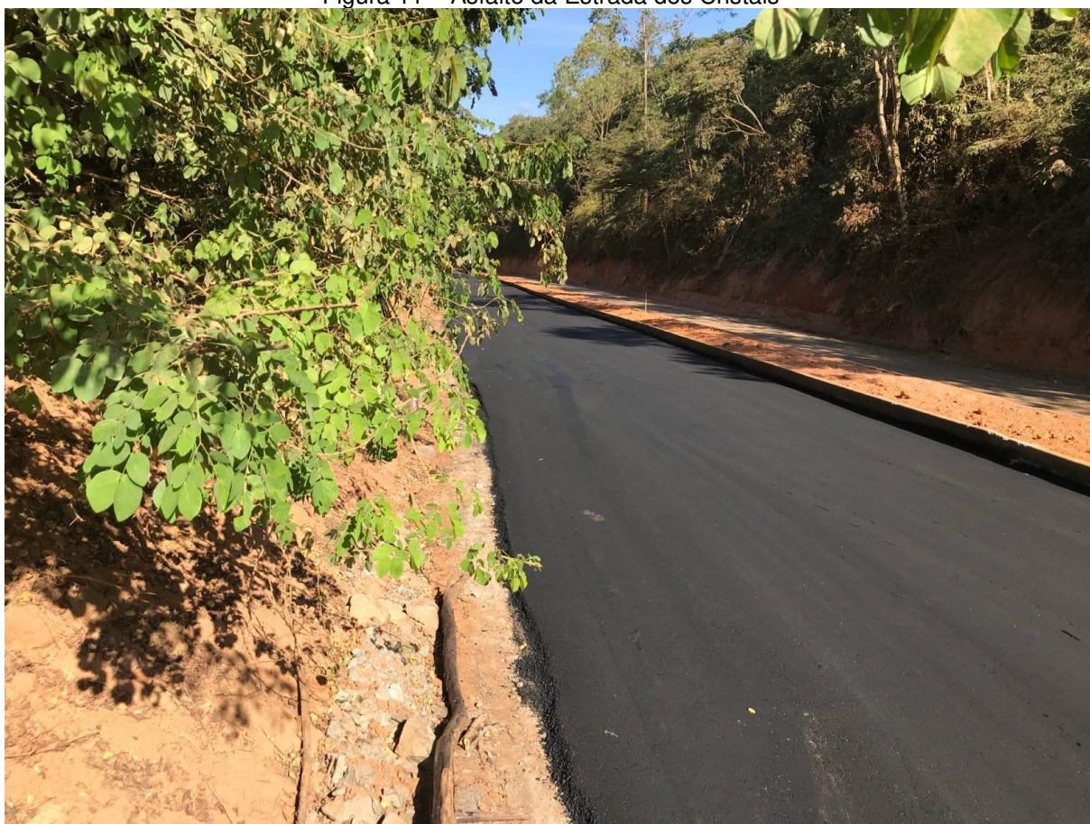
Figura 11 – Asfalto da Estrada dos Cristais
