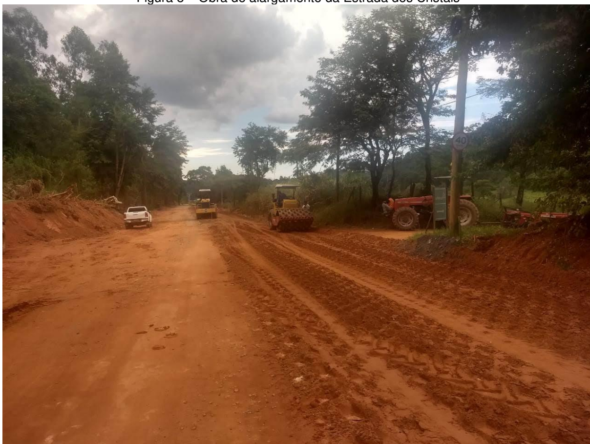
Figura 8 – Obra de alargamento da Estrada dos Cristais
