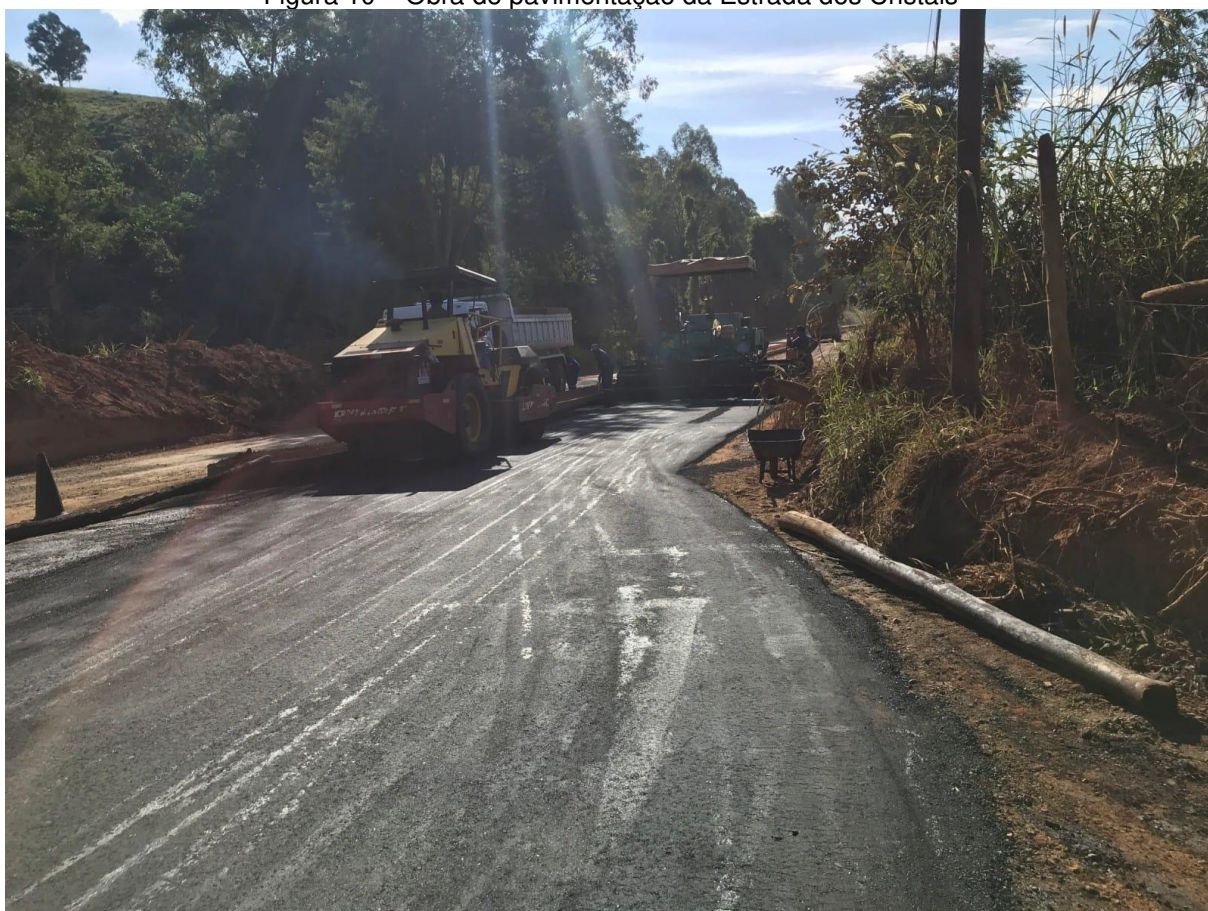
Figura 10 – Obra de pavimentação da Estrada dos Cristais
