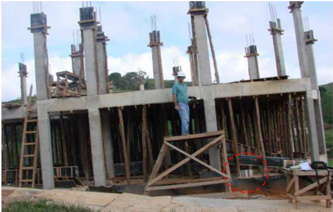
Figura 32 - Obra 3 - concreto com f_{ck} = 30,0 MPa.
