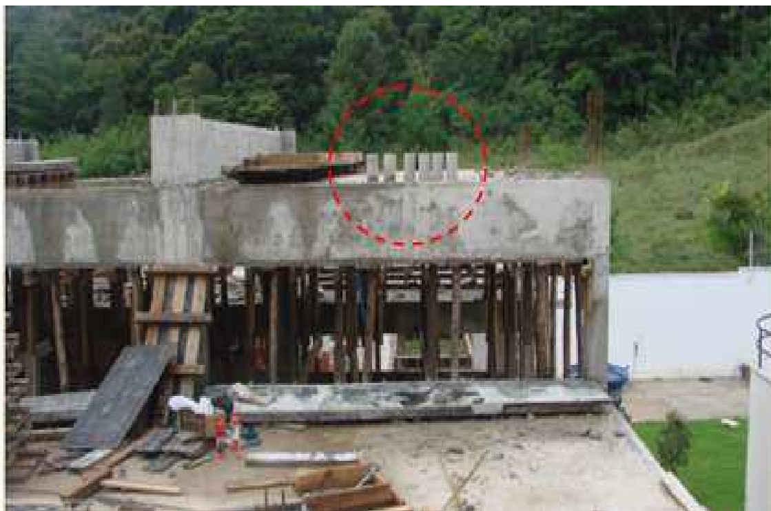
Figura 30 - Obra 1 - concreto com f_{ck} = 20,0 MPa.
