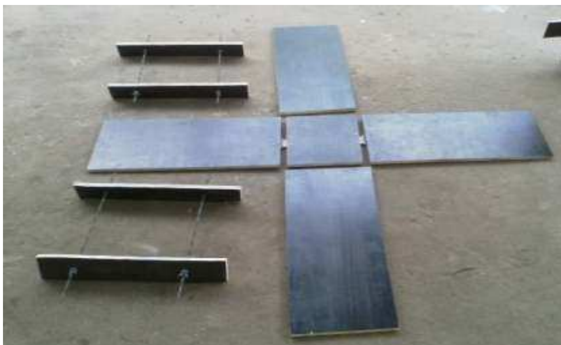
Figura 27 – Conjunto de elementos de uma forma em compensado plastificado
