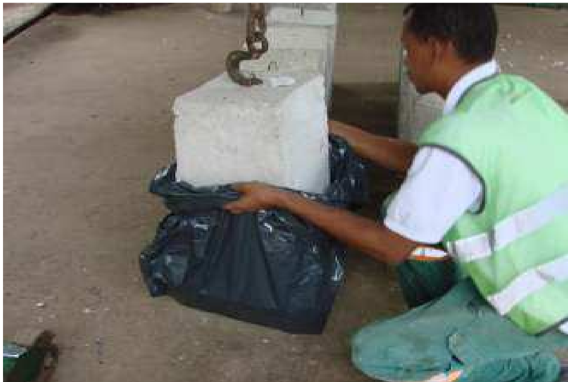
Figura 35- Içamento de um prisma de concreto com auxílio de uma “girafa”.
