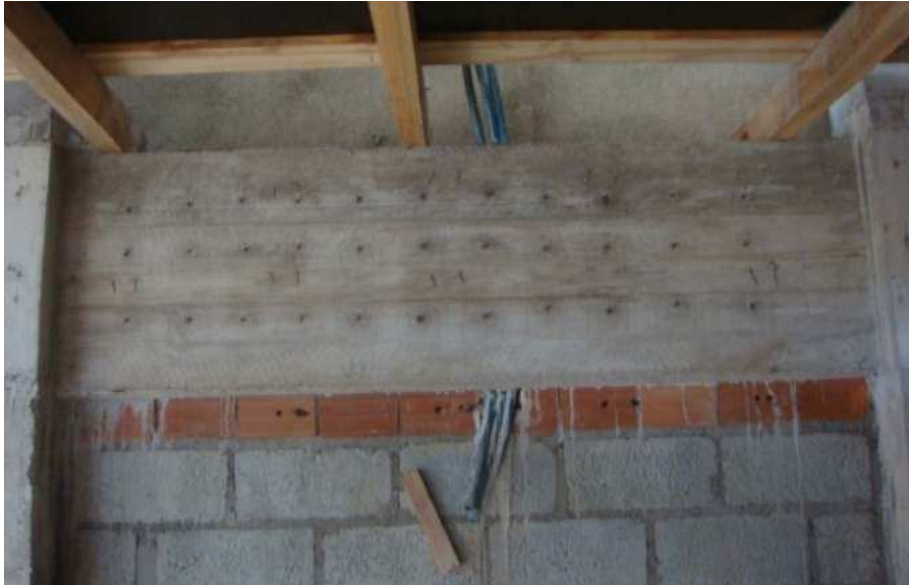
Figura 52 - Avaliação da homogeneidade do concreto em uma viga.
