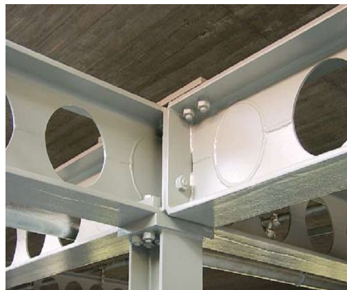
Figura 2.7 – Detalhe do fechamento de alvéolos na região de apoio das vigas (ARCELORMITTAL, 2012).
