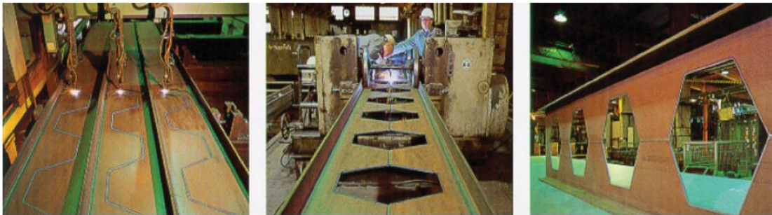
Figura 1.1 – Fabricação de viga castelada: corte com máquinas CNC 1 e soldagem (GEMPERLE, 2007).
