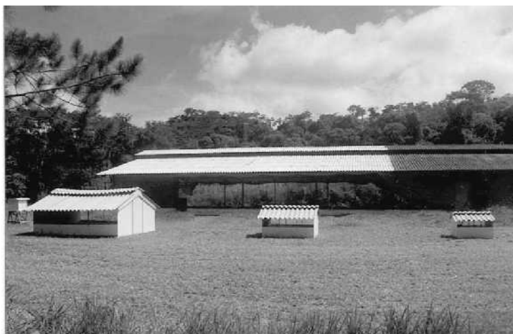
Figura 3.1. Vista da extremidade do galpão em que o telhado foi limpo para a realização da pesquisa.
