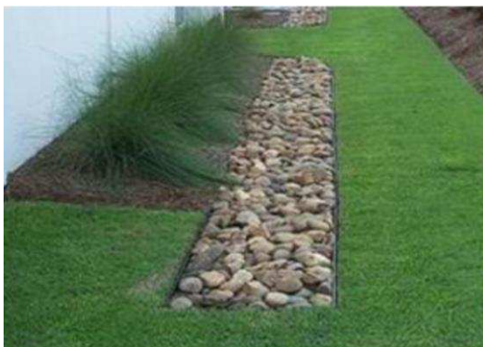
Figura 2-3 Trincheira de Infiltração
