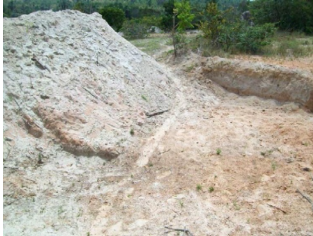
Figura 08: Tanque para captação de água de chuva.
