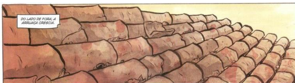
Figura 34: O Alienista . Telhado. (p. 39).
