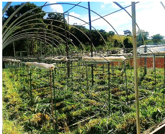
Figura 10 - Vista da estrutura de cobertura dos lisímetros com o plástico enrolado.
