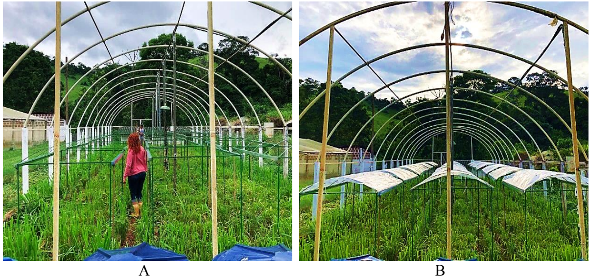
Figura 9 - Montagem das estruturas de cobertura dos lisímetros (A) e disposição das estruturas já montadas (B).
