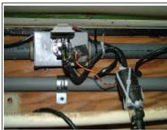
FIGURA 10. Detalhe do Sensor de Corrente Elétrica Instalado no Cabo de Energia do Ventilador, destinado a monitorar o tempo de funcionamento do mesmo.
