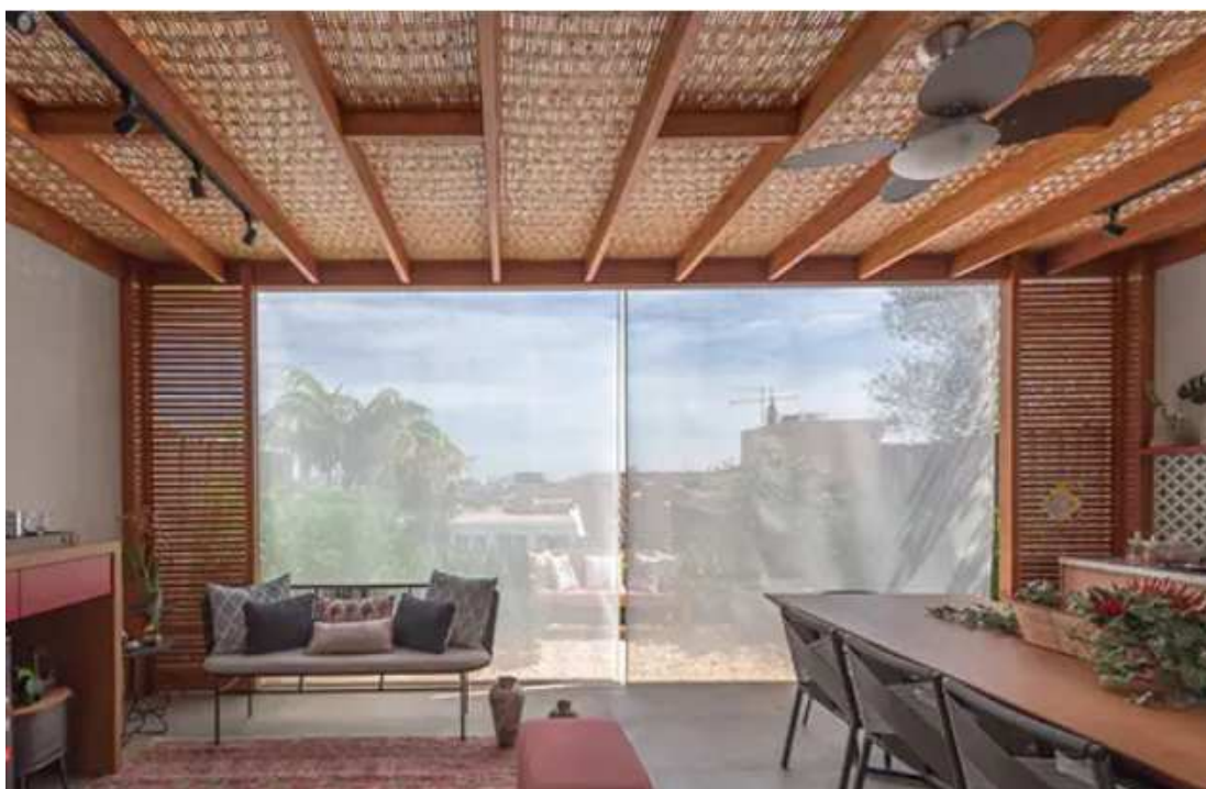
Figura 10 - Forro de bambu em ambiente interno
