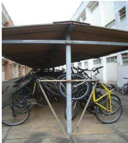
Figura 13 – Bicicletário entre o Alojamento Novo e Novíssimo. Fonte: Clara Pimenta.
