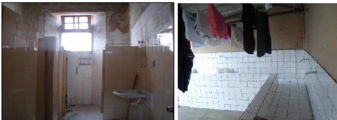
Figuras 05 e 06 – Banheiro coletivo e lavanderia coletiva do Alojamento Velho.
