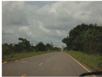
Figura: Rodovia Estadual RO-010. Fonte: Áurea Silva, Fevereiro/2015.
