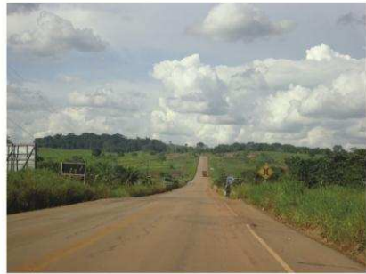
Figura: Rodovia Estadual RO-489. Fonte: Áurea Silva, Fevereiro/2015.
