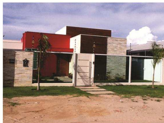
Figura : Residência Alvenaria. Fonte: SILVA, Áurea. 2015.
