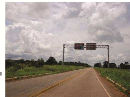
Figura: Rodovia Estadual, RO-094. Fonte: Áurea Silva, Fevereiro/2015.
