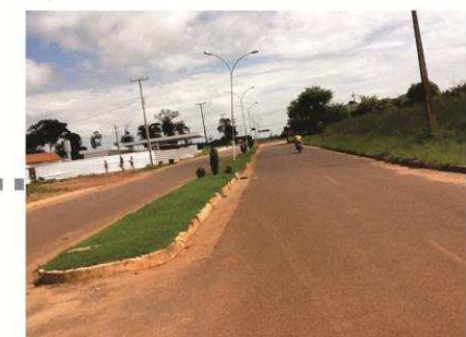
Figura: Rodovia Estadual, RO 391. Fonte: Áurea Silva, Fevereiro/2015.
