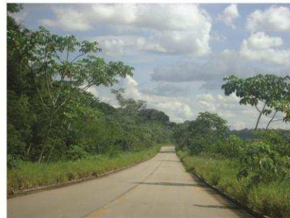
Figura: Rodovia Estadual, RO-492. Fonte: Áurea Silva, Fevereiro/2015.
