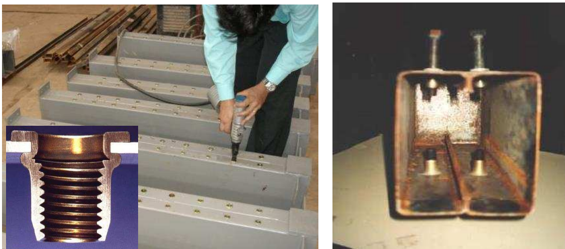
Figura 2-2. Sistema de conexão com rebite com rosca interna e parafuso sextavado (OLIVEIRA, 2007).
