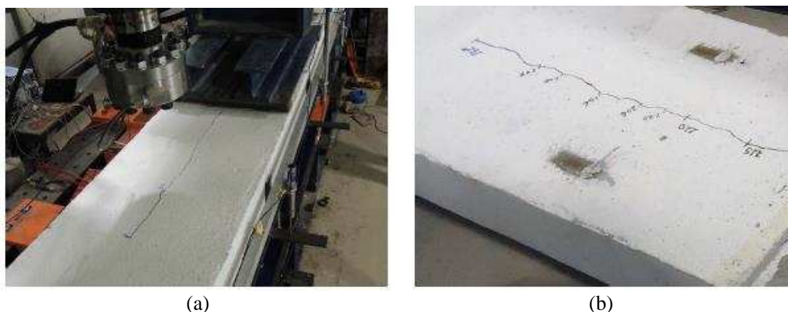
Figura 3-44. Surgimento de uma fissura longitudinal na face superior da laje de concreto, no plano do conector: (a) VM_Crest_1; (b) VM_Crest_2 (ALVES, 2014).
