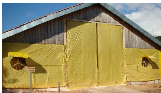
Figura 9 - Exaustores usados no sistema de ventilação mínima por pressão negativa.
