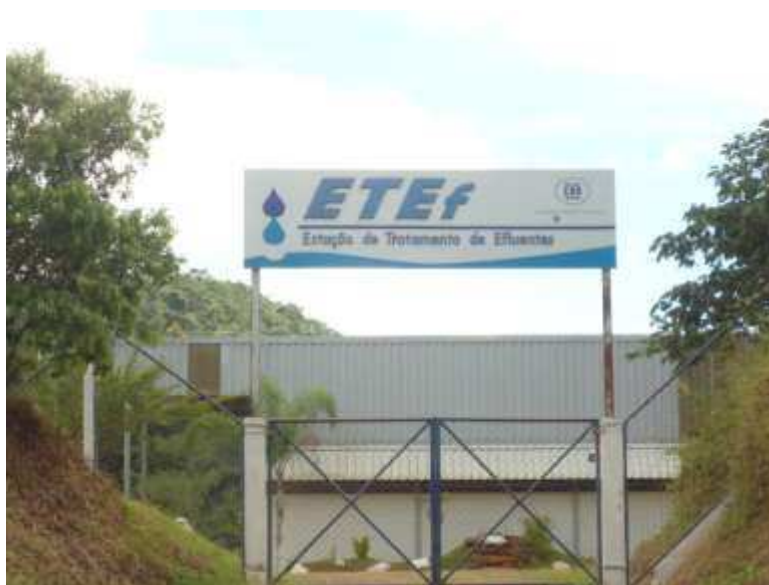
Figura 12: Imagem da Estação de Tratamento de Efluentes da CBA em Itamarati de Minas
