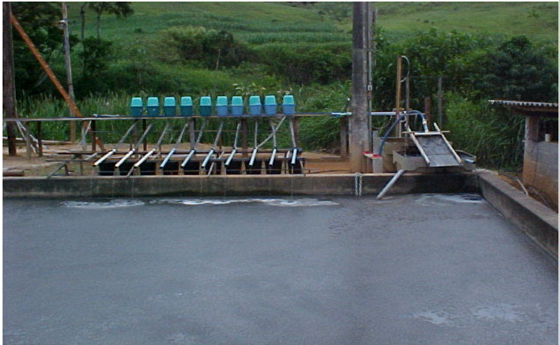
Figura 2 - Vista do filtro de tela e da bancada de coleta de vazão do microaspersor.
