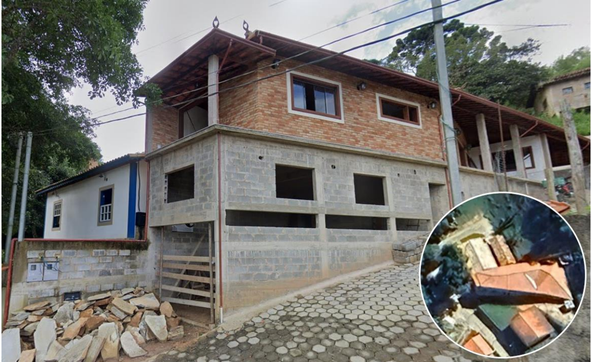
Figura 15 - Exemplo de construção recente, colada à divisa, que descumpra a legislação
