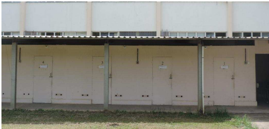
Figura 1. Vista externa da área experimental constituída de quatro câmaras climáticas.
