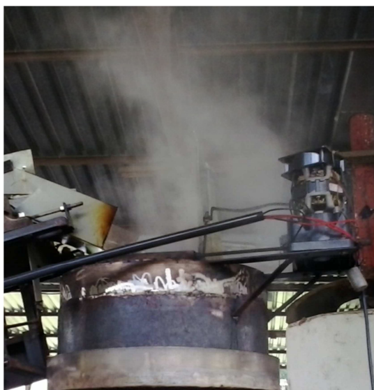
Figura 41 - Sistema de abertura em pleno funcionamento do reator.
