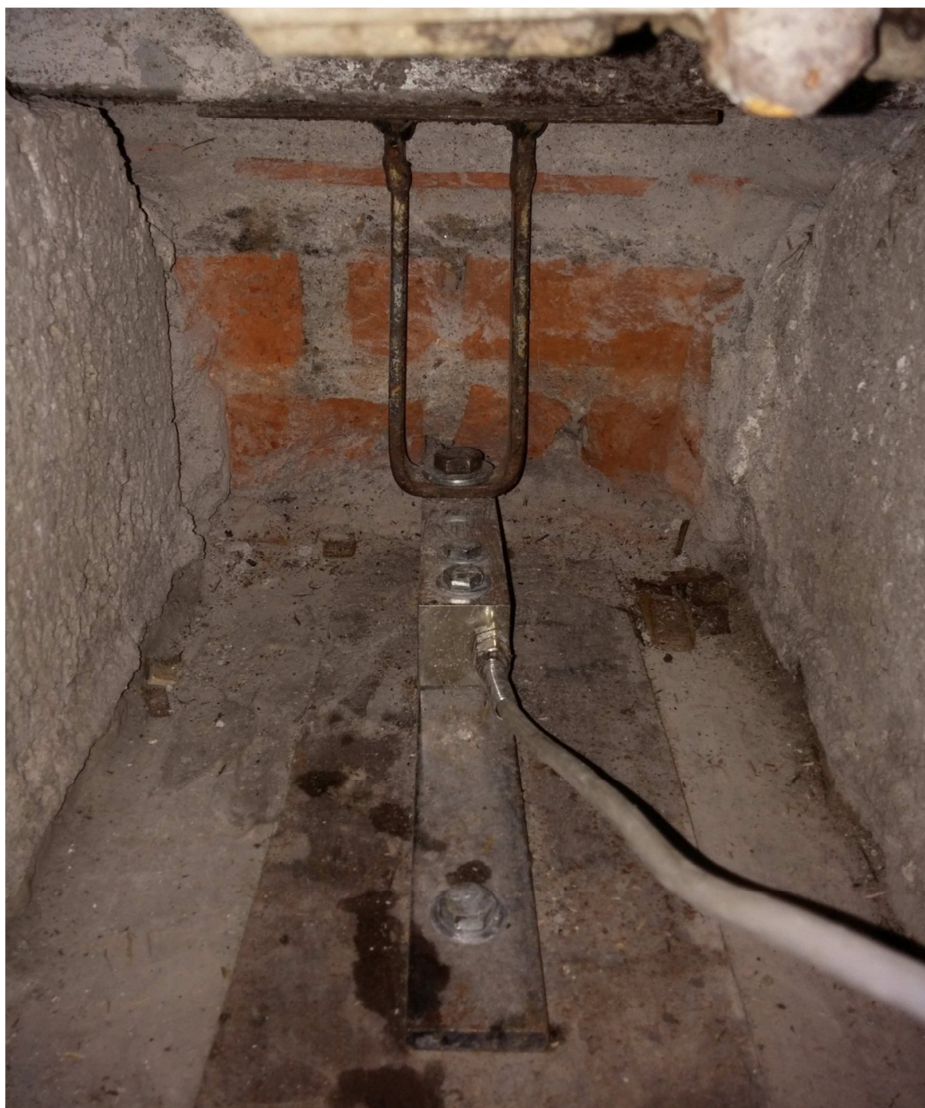
Figura 28 - Montagem da célula de carga embaixo do gaseificador.
