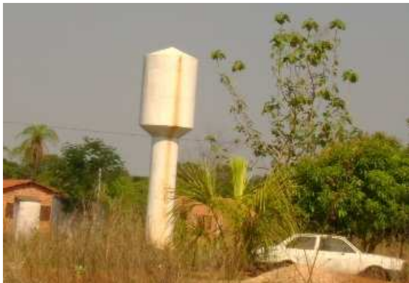
Figura 10 – Reservatório para abastecimento de água na agrovila do PA Barranco do Mundo, TO, 2008.
