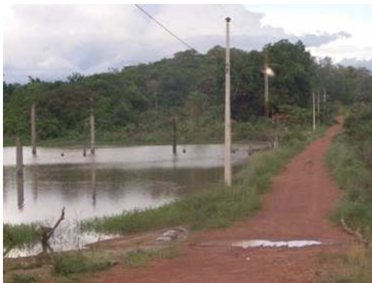
Figura 23 – Vista da represa e rede de energia elétrica, no PRA Provi, TO, 2008.
