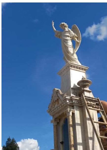
Figura 8 - Reparos no Túmulo de Eleotério de Andrade
