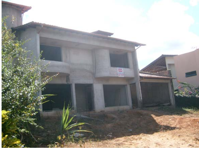
Figura 31 – Uma das casas em construção no condomínio.
