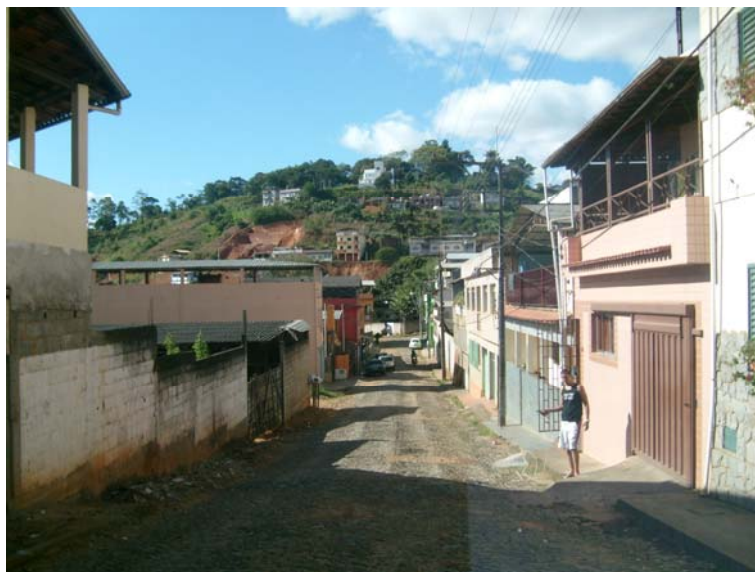
Figura 27 – Um das ruas do João Braz. Além da falta de infraestrutura como calçamento, percebe-se ao fundo a ocupação de uma área com declividade acentuada.
