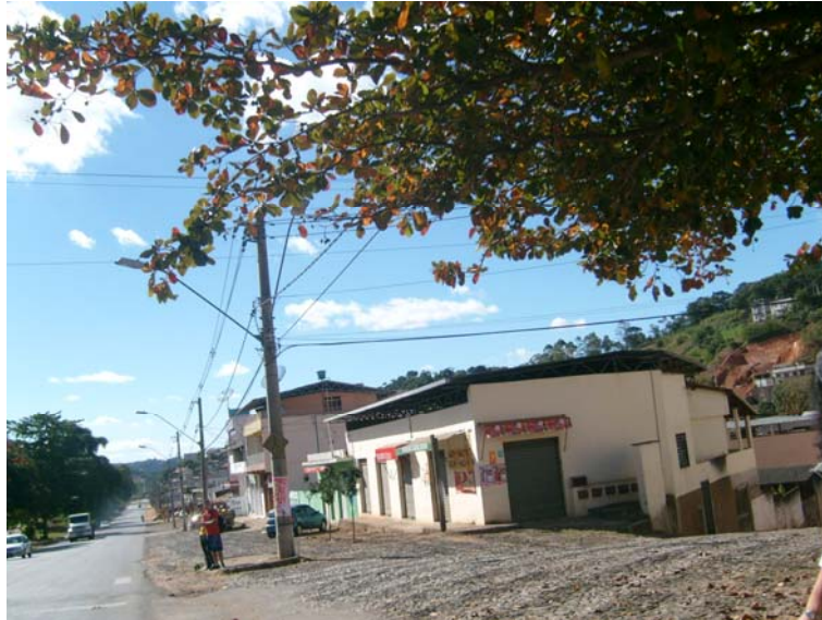
Figura 26 – Estabelecimentos comerciais do João Braz ao longo da Avenida Marechal Castelo Branco. Observa-se a falta de calçamento e segurança para os pedestres.
