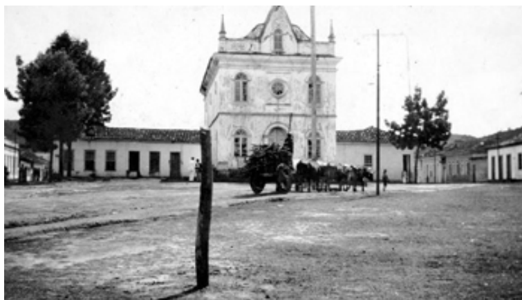
Figura 11 – Largo do Rosário com a Capela do patrimônio de Santa Rita. Foto do final do séc. XIX.
