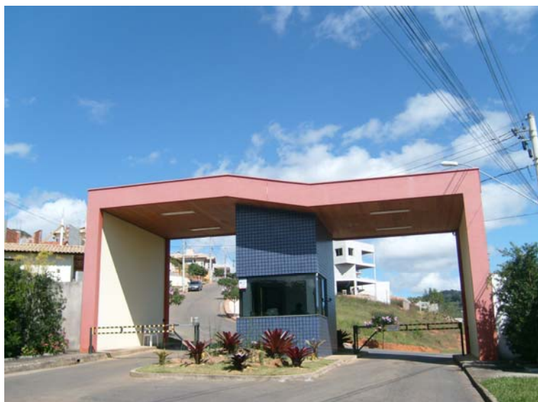
Figura 5 – Portaria do Condomínio Residencial Monte Verde, no bairro Romão dos Reis. São 54 lotes, contando hoje com 15 casas construídas. Como está em construção, ainda não tem área de lazer coletiva em funcionamento. Sua edificação começou a partir do ano 2000.
