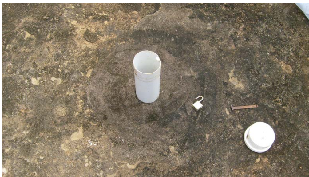
Figura 17 - Poço de monitoramento.
