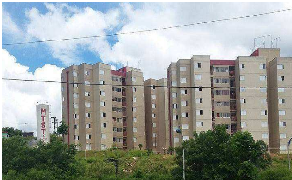
Figura 12. Condomínio João Cândido A
