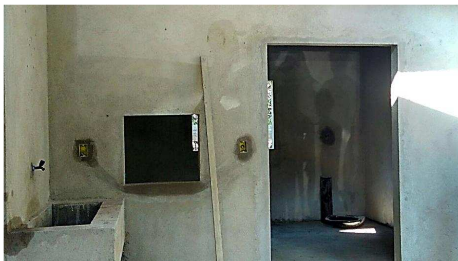
Figura 6: Espaço em construção para processamento de mandioca, segundo as especificações dadas pela Vigilância Sanitária Municipal.
