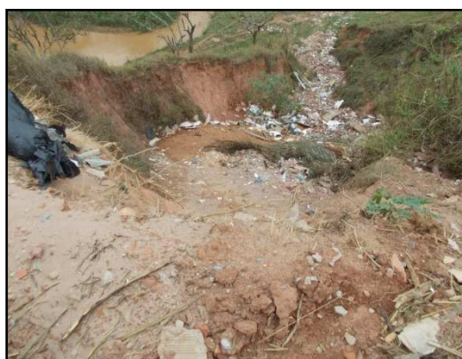
Figura 13: Lançamento de lixo e entulho em encosta. Fonte: Arquivo do Autor
