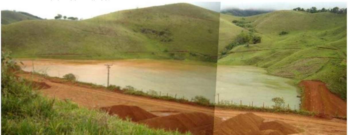
Figura 5 – Barragem São Francisco no córrego Bom Jardim antes do incidente.
