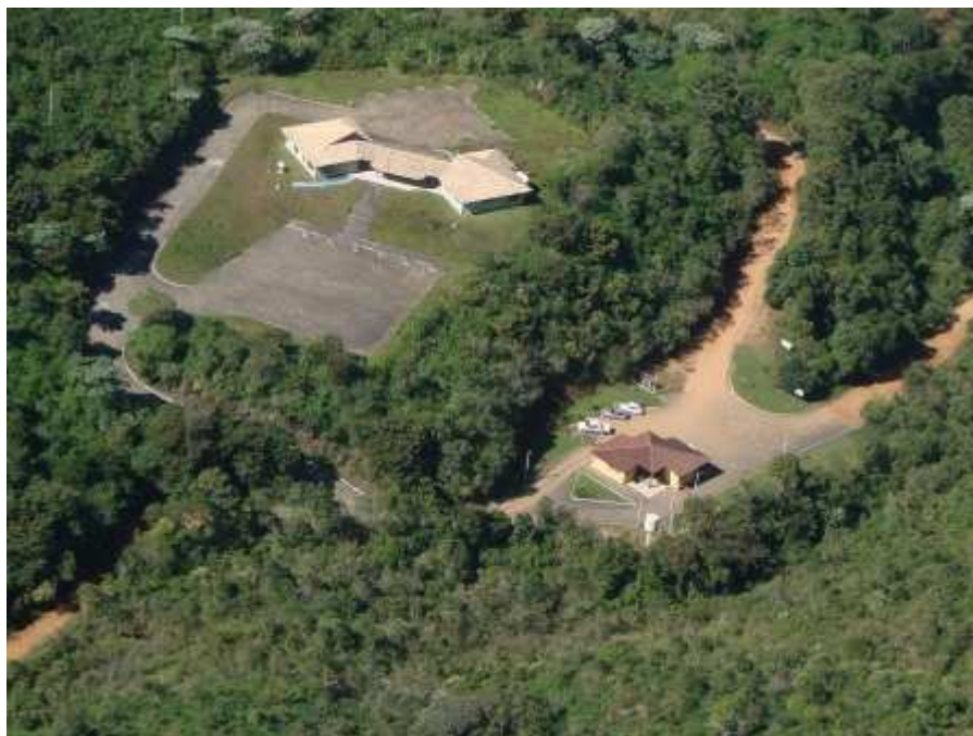
Figura 23: Vista aérea da portaria de Pedra menina. Na parte inferior da fotografia, está situada a portaria e na parte superior o centro de visitantes.
