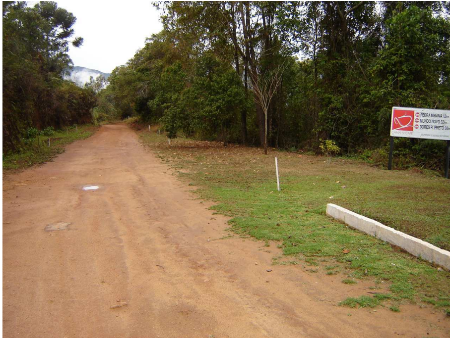
Figura 24: Estrada que liga a Portaria de Pedra menina ao centro de Dores do Rio Preto em fase de construção.
