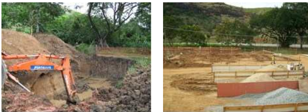
Figura 8 – Registro fotográfico das obras do Residencial Atalaia.
