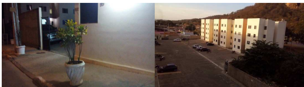
Figura 1 – Vista da entrada do Residencial Atalaia, do estacionamento e vista parcial dos blocos.
