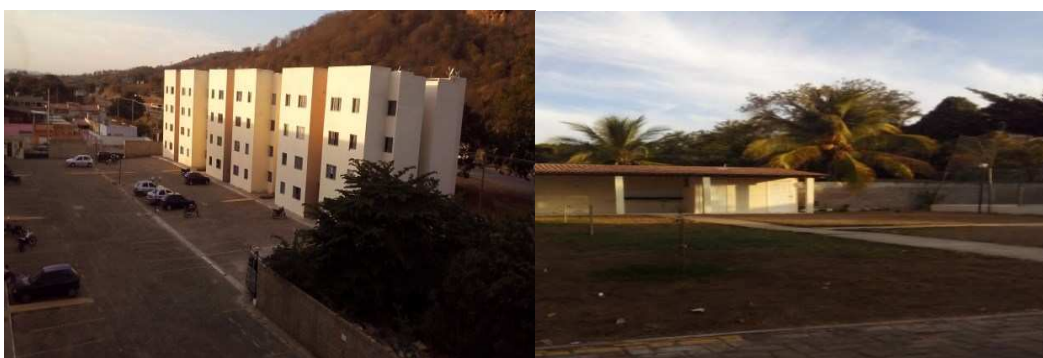
Figura 11 – Vista parcial da área externa – estacionamento e blocos do Residencial Atalaia e vista da área social – área coberta e gramado.
