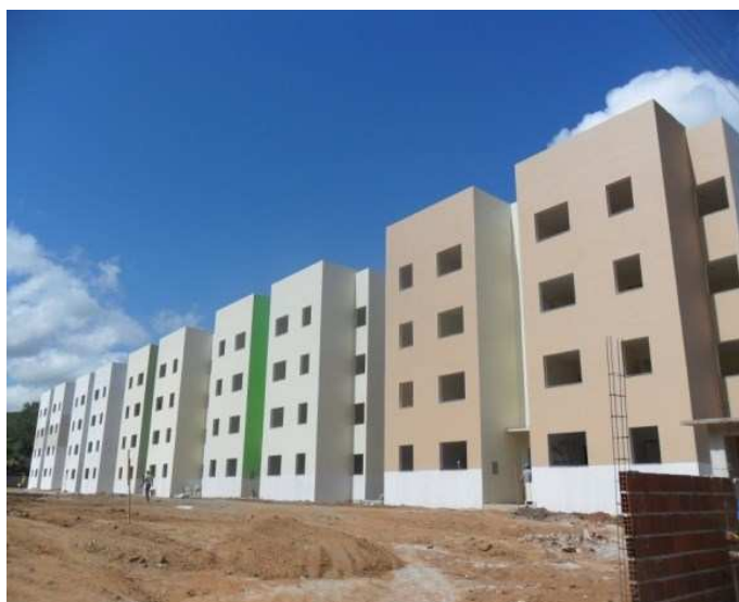
Figura 9 – Vista dos blocos do Residencial Atalaia em fase de acabamento.
