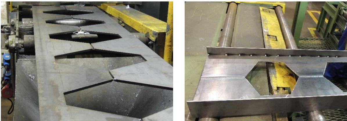
Figura 3 – Vigas casteladas soldadas.
