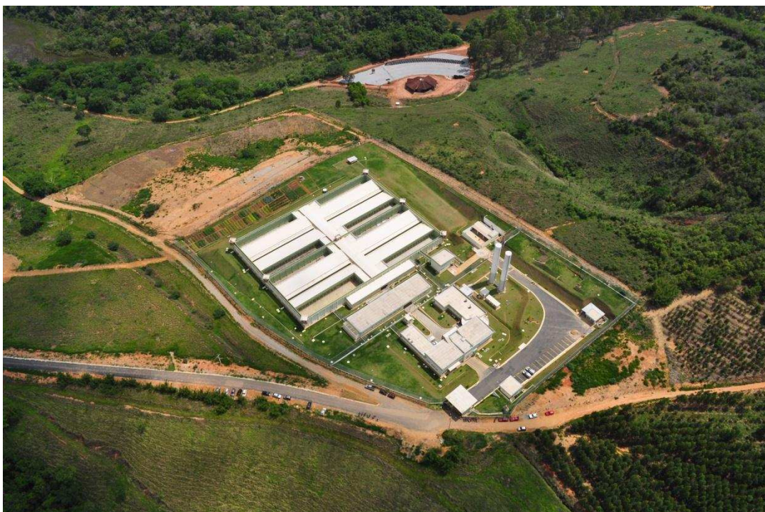
Figura 9: Foto aérea do Complexo Penitenciário do Município de Ponte Nova/MG
