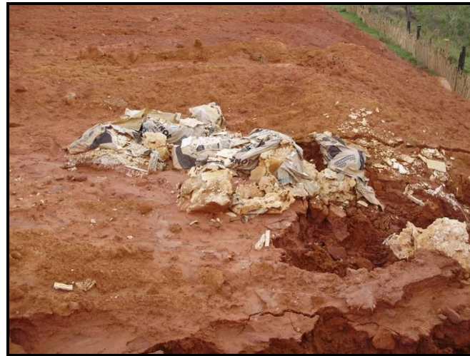
Figura 4.16: Pontos de erosão, devido à ausência de compactação adequada; e presença de resíduos de gesso, que deveriam ter destinação específica.
