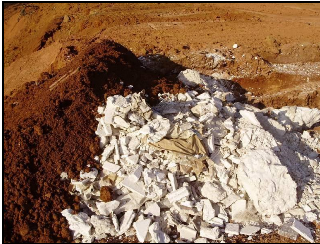
Figura 4.16: Pontos de erosão, devido à ausência de compactação adequada; e presença de resíduos de gesso, que deveriam ter destinação específica.
