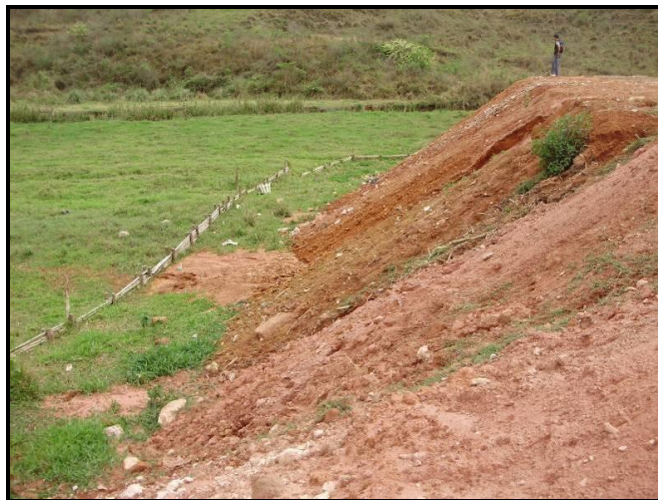
Figura 4.15: Plataformas de RCD elevadas e taludes com grandes inclinações e sem contenção adequada.
