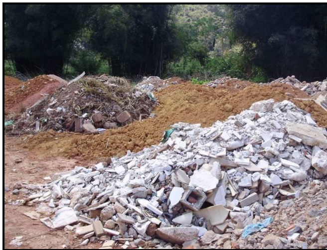
Figura 4.14: Disposição de RCD e solo em pilhas sem manejo adequado. Verifica-se presença de materiais recicláveis e gesso junto aos resíduos.
