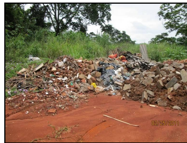
Figura 4.14: Disposição de RCD e solo em pilhas sem manejo adequado. Verifica-se presença de materiais recicláveis e gesso junto aos resíduos.
