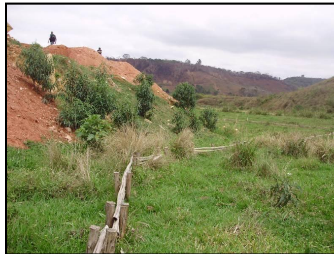
Figura 4.15: Plataformas de RCD elevadas e taludes com grandes inclinações e sem contenção adequada.
