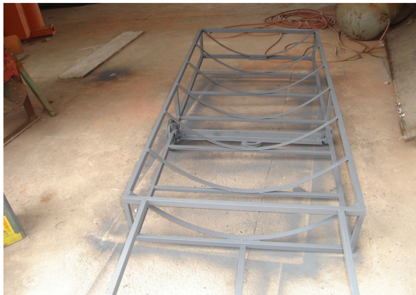
Figura 3.6: Estrutura construída em metalon e barras chatas, que será usada na montagem do coletor.
