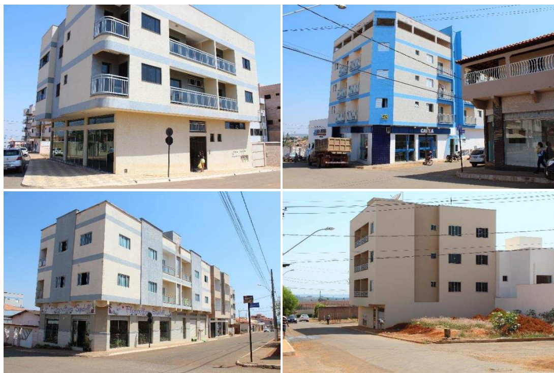
Figura 15 — Edificações sem parâmetros urbanísticos em Rio Paranaíba, MG
