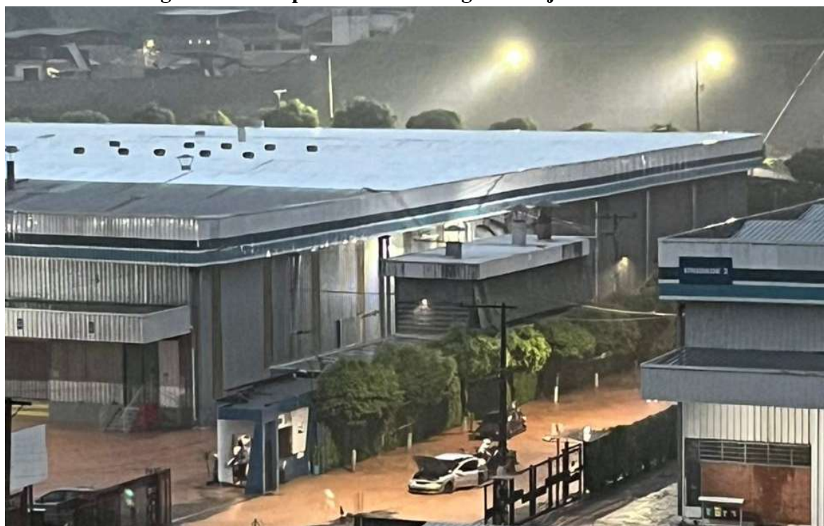
Figura 46 – Galpão industrial alagado em janeiro de 2024
