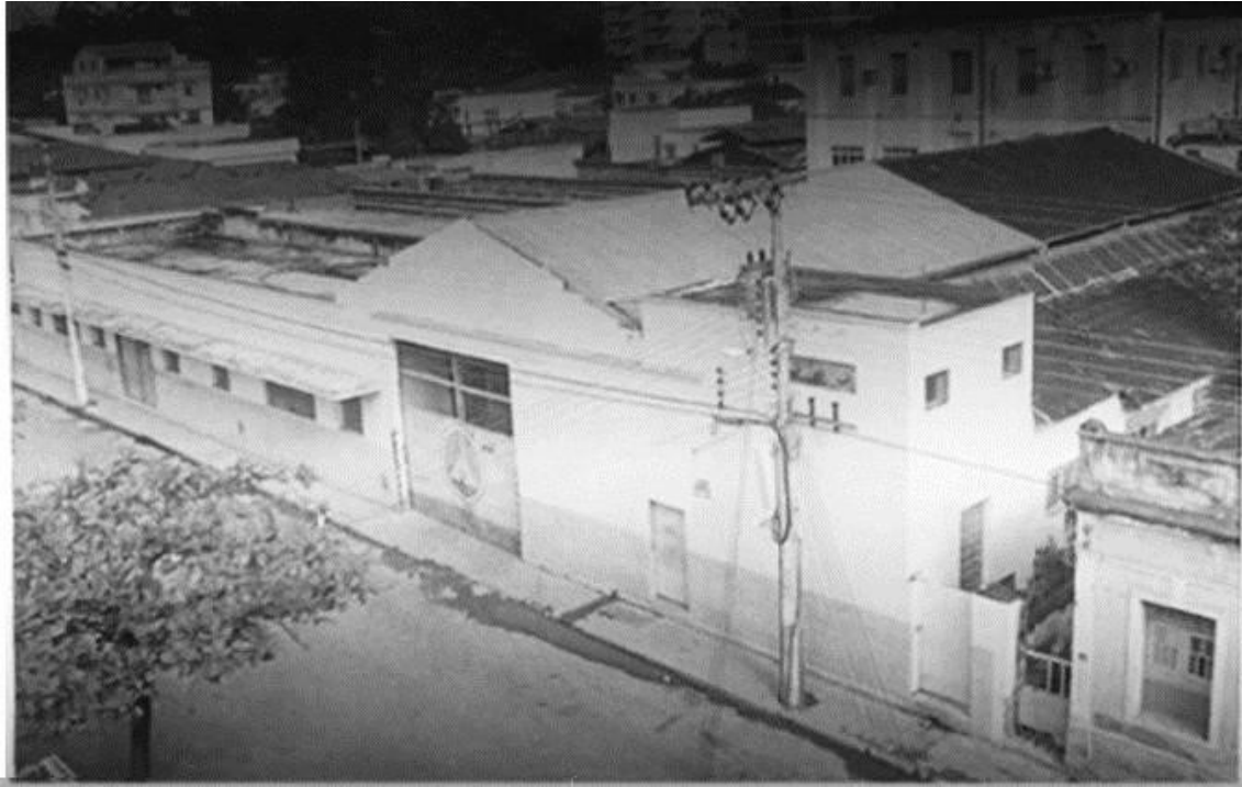
Figura 32 – Galpão Itatiaia localizado na Avenida Raul Soares
