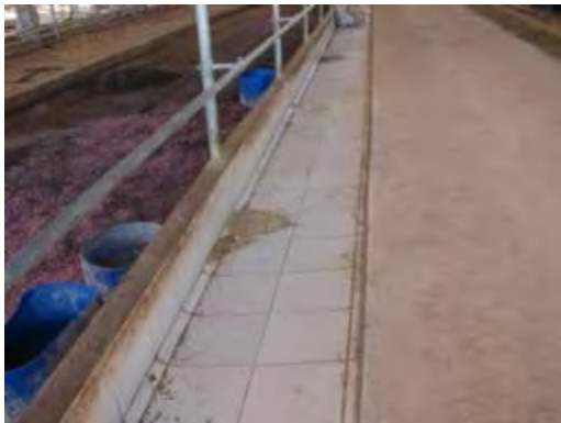
Figura 160– Comedouro revestido com azulejo
