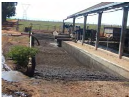
Figura 134 - Deposito de dejetos.
