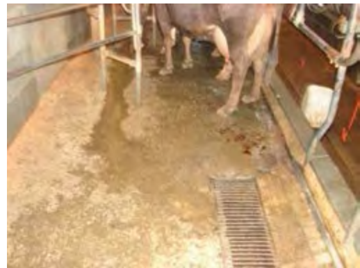
Figura 22 – Canaleta para coleta de dejetos na sala de ordenha
