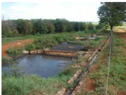
Figura 110 – Tanques de decantação de dejetos
