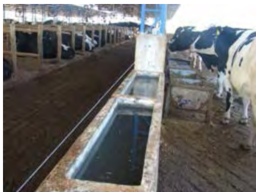
Figura 67 – Bebedouros de concreto revestido com azulejo.
