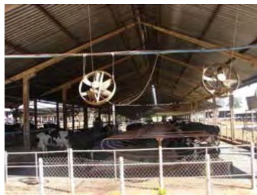
Figura 205– Baias de descanso com ventiladores
