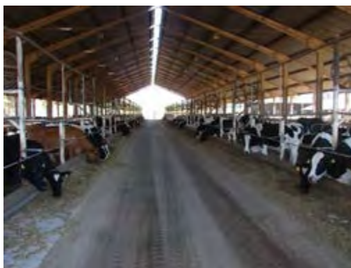
Figura 209 – Corredor de alimentação (Corredor central)
