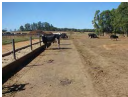
Figura 172 – Área com piso de concreto ao longo do comedouro.
