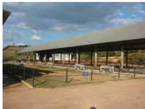
Figura 48– Distribuição de bebedouros ao longo Do galpão de confinamento.
