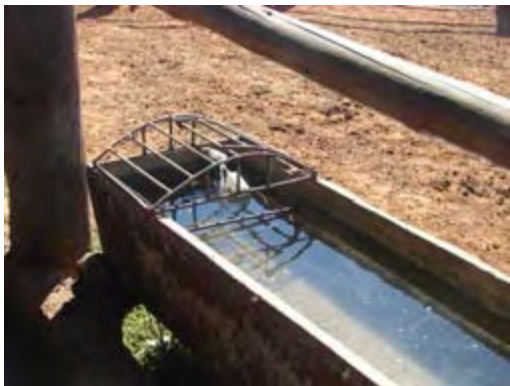
Figura 31 –bebedouros em concreto.
