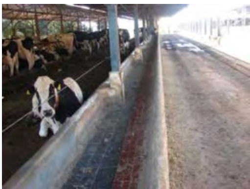
Figura 131 – Comedouro com revestimento em ardósia e cerâmica
