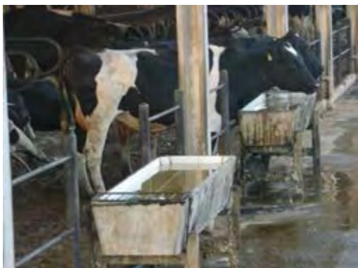
Figura 47 –Bebedouros de concreto armado revestido com azulejo.
