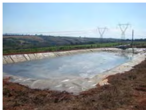
Figura 135– Lagoa de estabilização de dejetos
