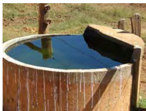
Figura 102 – Bebedouros de concreto armado
