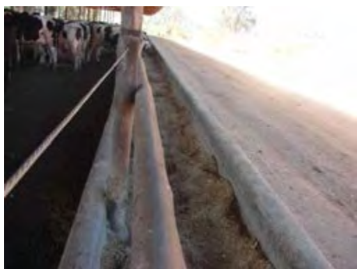
Figura 29 – Comedouros ao longo do galpão
