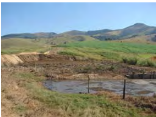
Figura 69 – Lagoa de estabilização de dejetos
