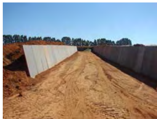
Figura 100 – Silo revestido com ardósia
