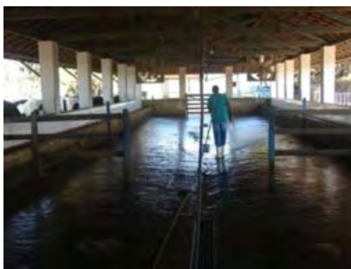
Figura 64 – Vista frontal do curral de espera e Sala de ordenha
