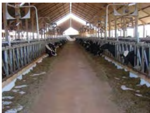
Figura 219 – Corredor de alimentação (Corredor central)
