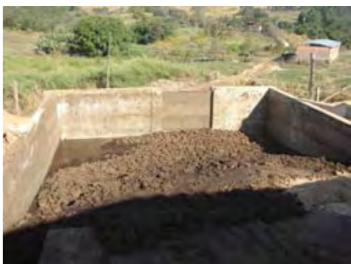
Figura 164– Caixa de decantação de dejetos
