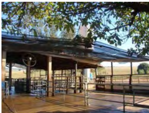
Figura 186 – Vista lateral do curral de espera, com cobertura em sombrite e sombreamento natural
