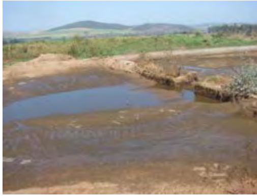
Figura 94– Lagoa de estabilização de dejetos
