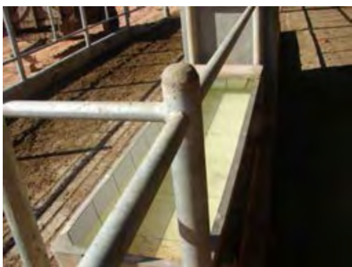
Figura 162 – Bebedouros de concreto revestido com azulejo.
