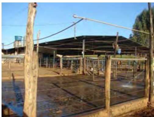
Figura 139 – Curral de espera descoberto perpendicular a sala de ordenha.
