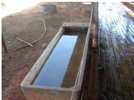
Figura 90 – Bebedouros de concreto ardósia revestido com azulejo.
