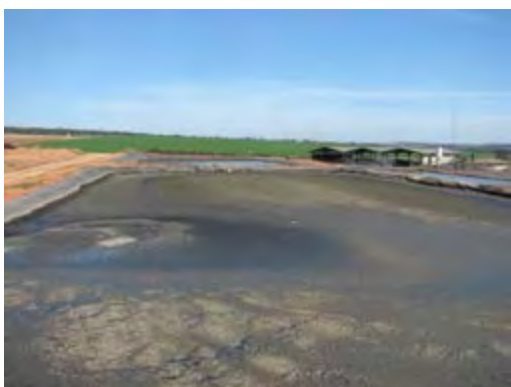
Figura 211 – Lagoa de estabilização de dejetos
