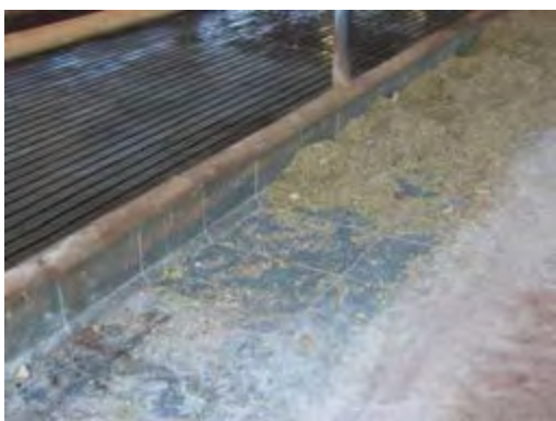
Figura 88 – Comedouro com revestimento em ardósia
