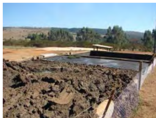
Figura 176 – Lagoa de estabilização de dejetos
