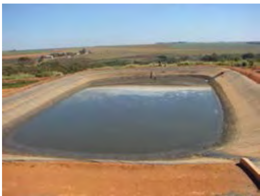
Figura 222– Lagoa de estabilização de dejetos
