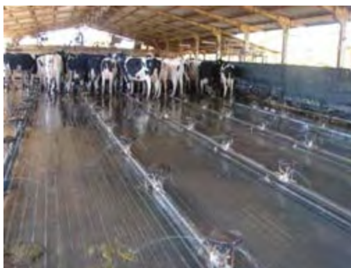
Figura 206 – Curral de espera com aspersores de limpeza
