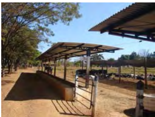
Figura 55 – Comedouros cobertos nos piquetes de confinamento.
