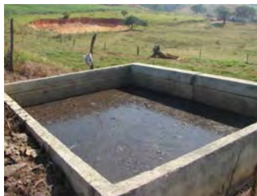
Figura 70 – Deposito de dejetos
