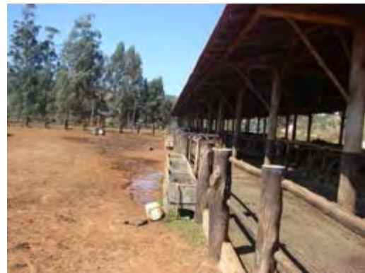
Figura 32 – Disposição de bebedouros ao longo do galpão de confinamento.
