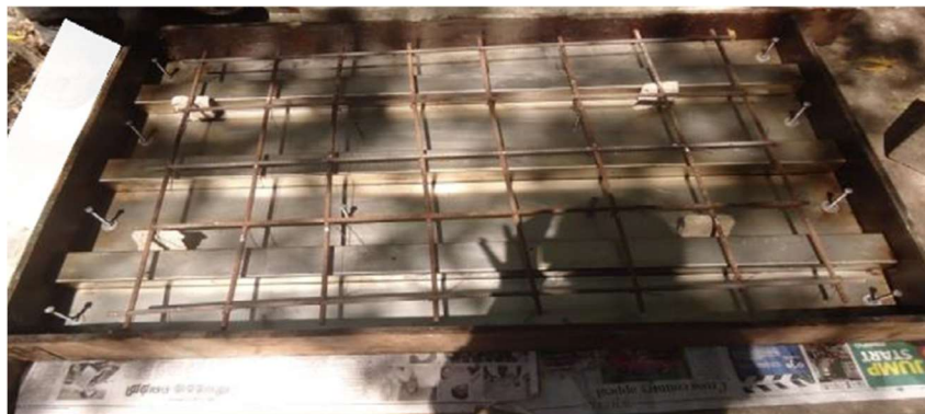
Figura 3.11 – Laje mista com conector tipo stud.
